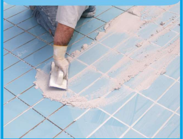
Relleno de las juntas con KERAPOXY
