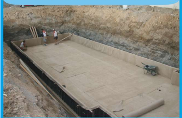
Aplicación de MAPEPROOF sobre la base de hormigón magro antes de la realización del fondo del vaso
