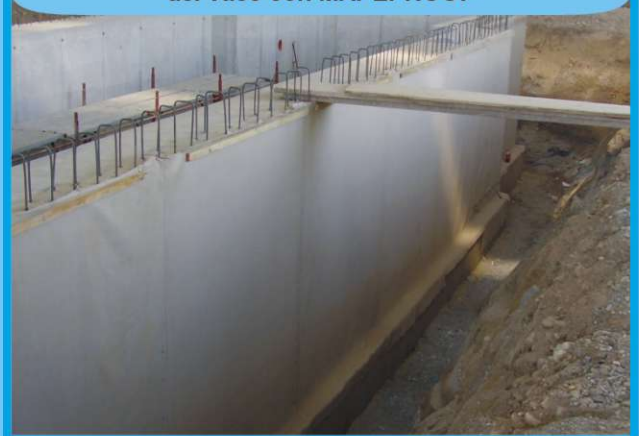
Impermeabilización de las paredes del vaso con MAPEPROOF
