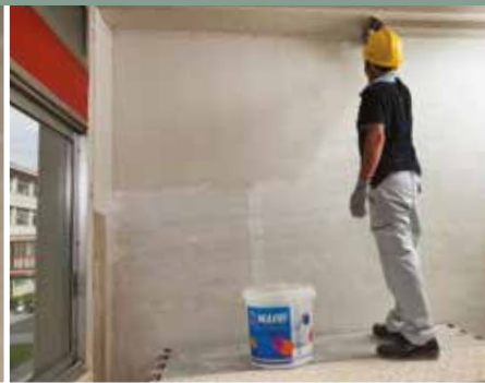
5 | Protección antisísmica mediante aplicación de MapeWrap EQ System sobre particiones - ITCG Teresio Olivelli - Darfo Boario Terme (BS)
