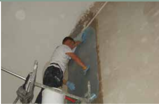
4 | Protección antisísmica mediante aplicación de MapeWrap EQ System sobre particiones - Escuela Alberto Pio - Carpi (MO)
