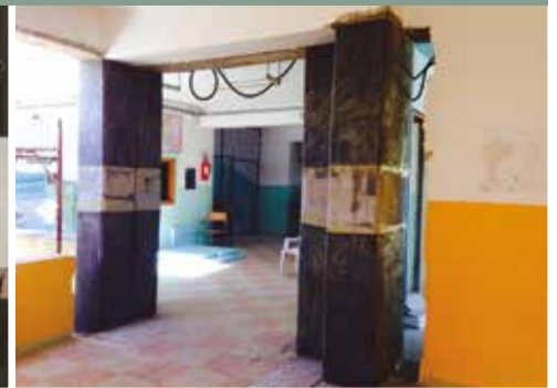
2 | Refuerzo a cortante de pilares con tejidos MapeWrap C Escuela primaria, Frazione Mirto - Crosia (CS)
