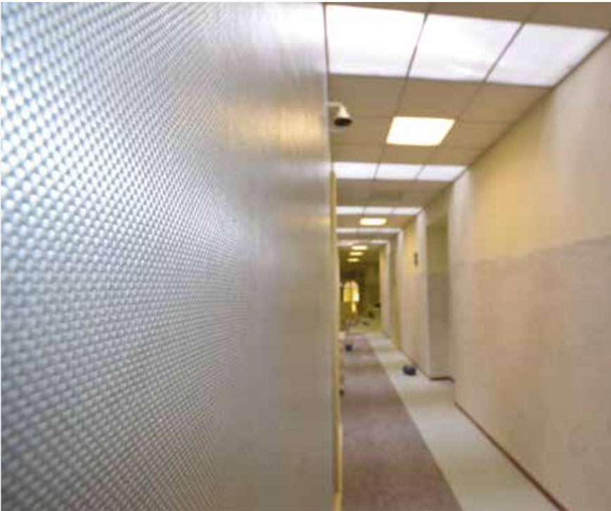
1 | Sistema anti-vuelco de las particiones interiores mediante colocación de MapeWrap EQ System Instituto Dante Alighieri - Gorizia
