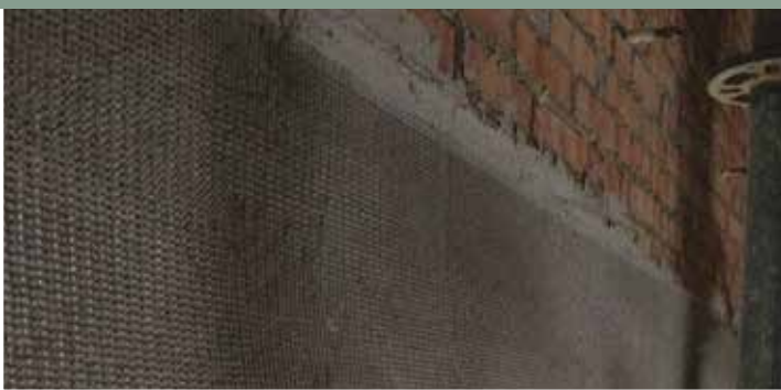
3 | Refuerzo a cortante de muros con Mapegrid G 220 y Planitop HDM Maxi Escuela primaria Sant'Agostino - Ascoli Piceno
