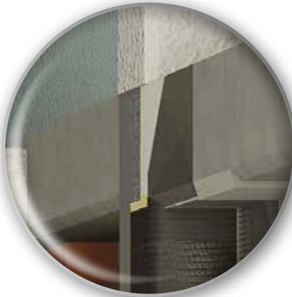
Refuerzo local de nudos viga-pilar mediante tejidos de fibra de carbono de la línea FRP System
