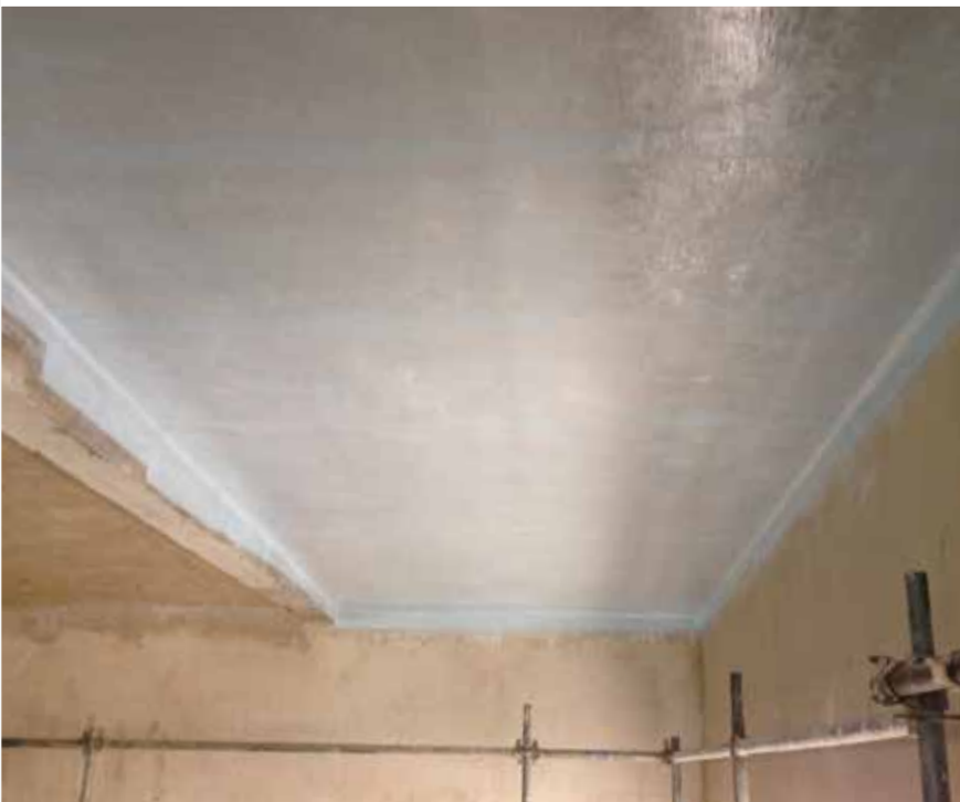
2 | Sistema anti-desprendimiento de elementos de los forjados mediante MapeWrap EQ System Escuela primaria Leonardo da Vinci en Pove del Grappa (VI)
