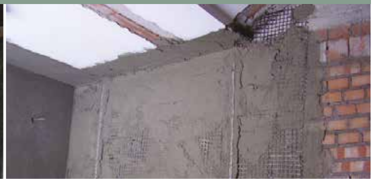
2 | Refuerzo a cortante de pilares con tejidos MapeWrap C Escuela primaria, Frazione Mirto - Crosia (CS)
