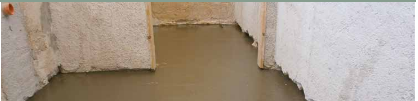
6 | Refuerzo de extradós de forjado mediante vertido de Planitop HPC Floor Escuela Mons. Giovanni Bacile - Bisacchino (PA)
