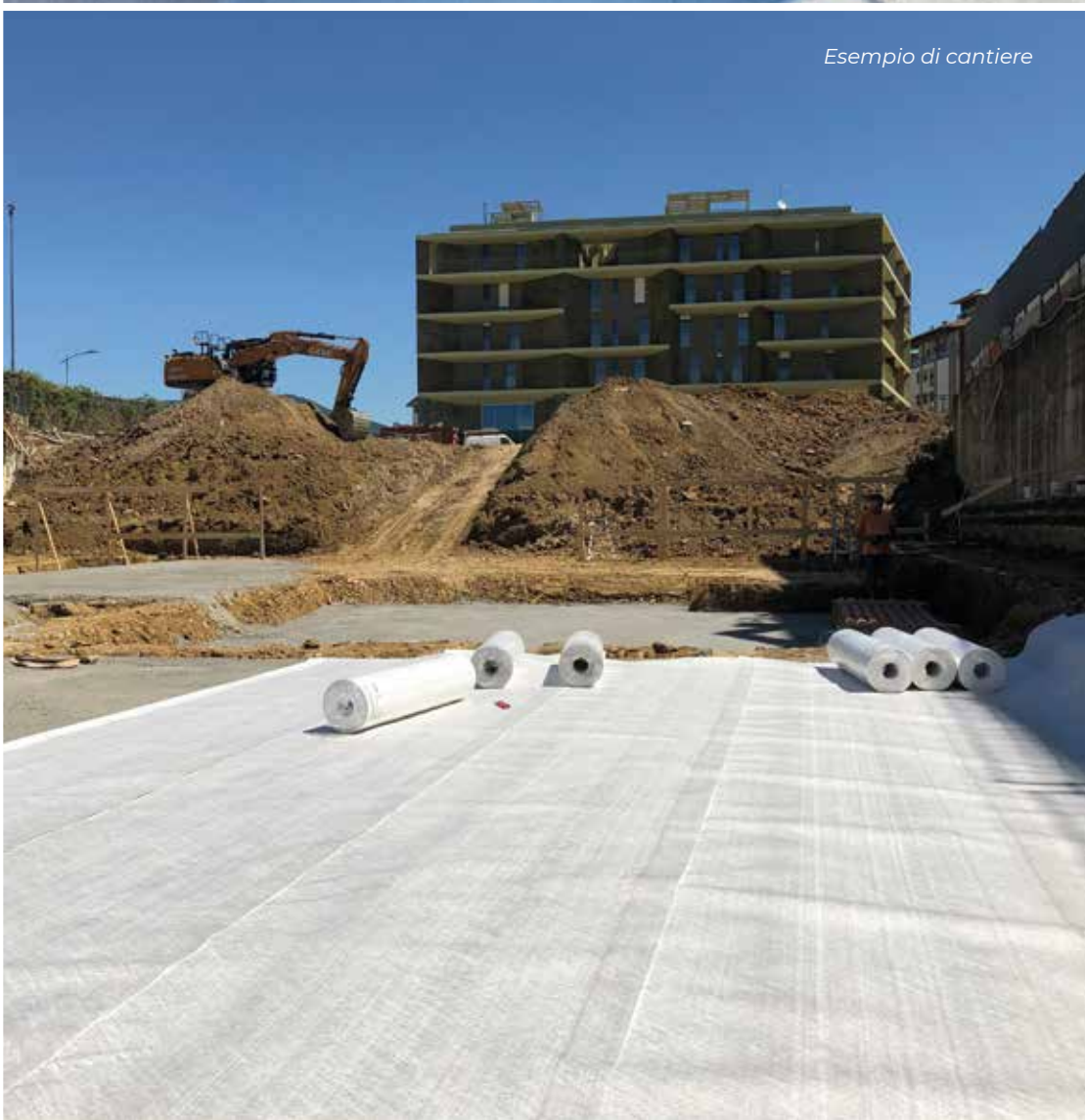
Posa delle armature
