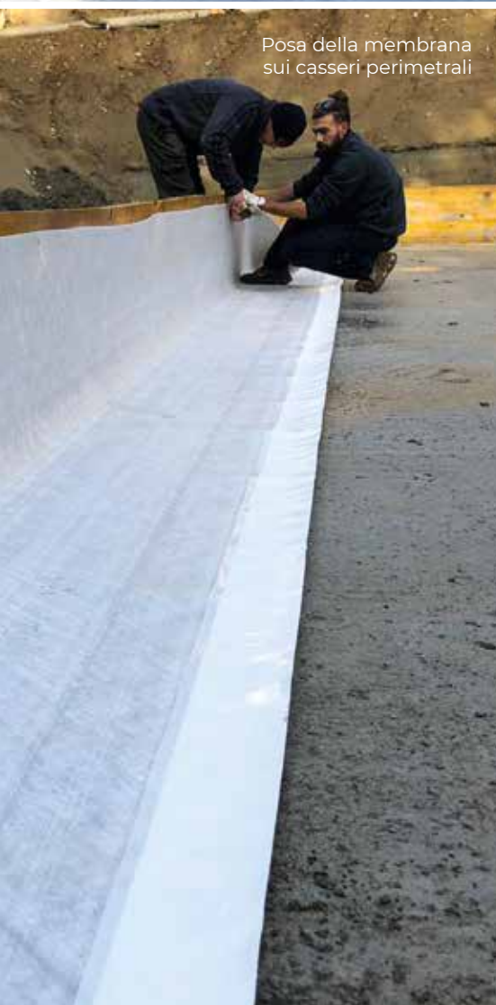
Impermeabilizzazione pali
