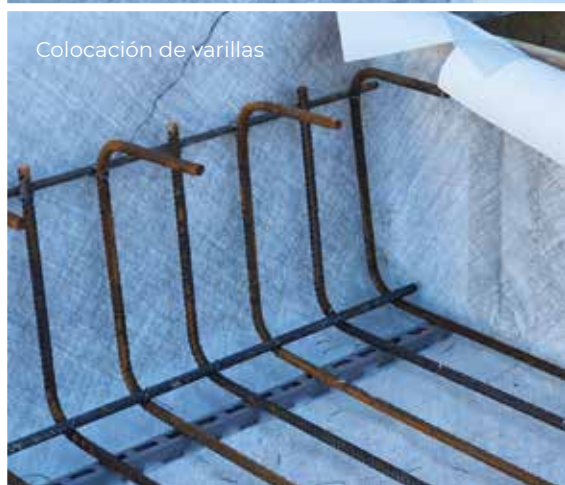
Impermeabilización de superficies horizontales
