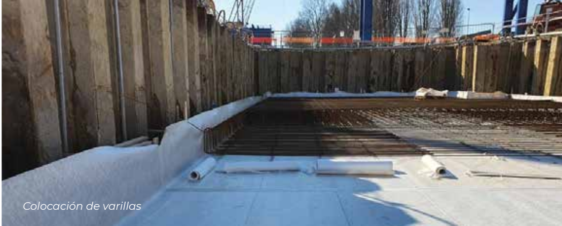
Ejemplo de obra con un sistema de impermeabilización
