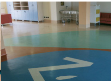
Ejemplo de colocación de PVC en - Casa de reposo San Martino - Italia
