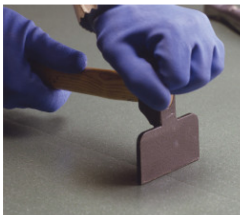
Masaje sobre la junta del pavimento
