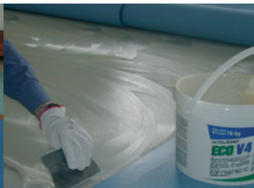
Aplicación de Ultrabond Eco V4SP - Casa de reposo San Martino - Italia
