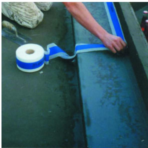
*Ejemplo de impermeabilización con Mapeband del encuentro entre la losa y el muro de un depósito*
