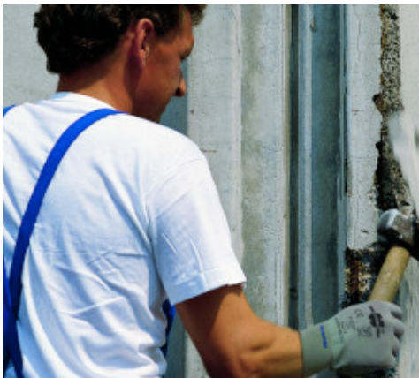
Demolición del hormigón degradado.
