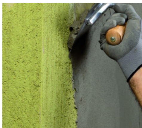
Aplicación de Planitop 210
