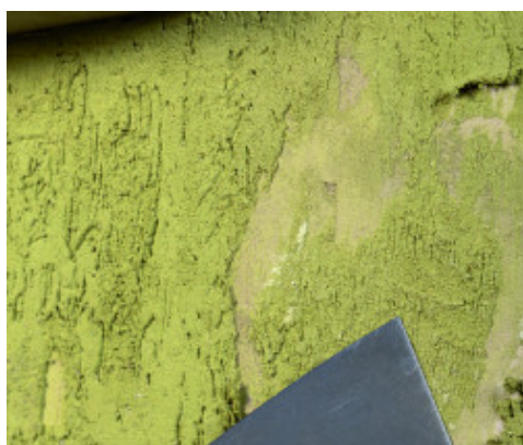
Eliminación del revestimiento plástico no adherente
