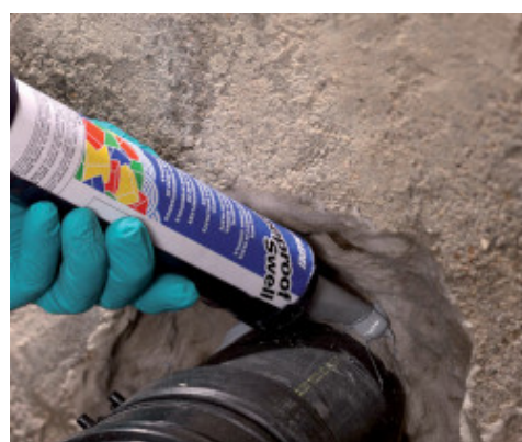
Aplicación de Mapeproof Swell alrededor del tubo
