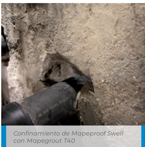
Pinchazo de la membrana de protección de Mapeproof Swell
