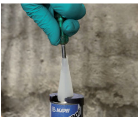
Pinchazo de la membrana de protección de Mapeproof Swell
