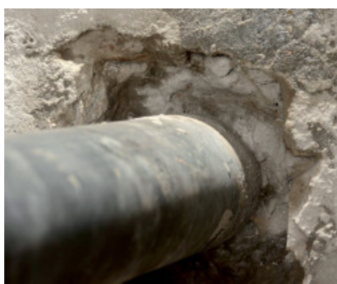
Demolición de la estructura alrededor del tubo
