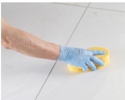
Limpieza y acabado de juntas con esponja de celulosa dura
