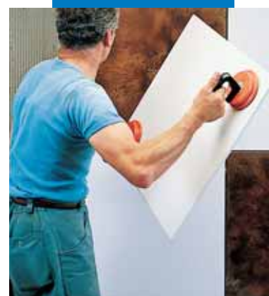
Colocación de KERAION en pared
