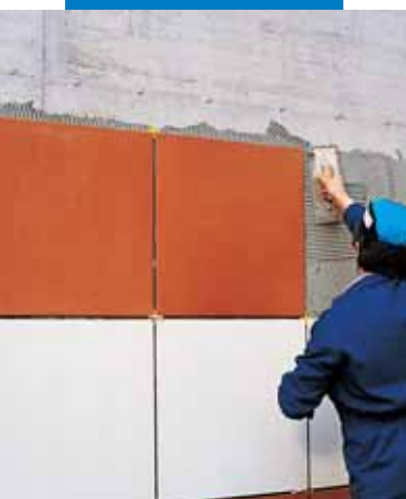
Colocación de grandes formatos con Kerabond+Isolastic
