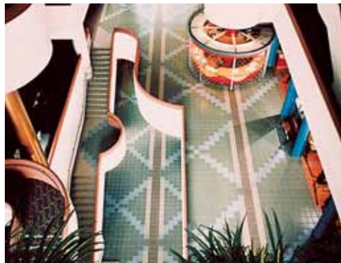
Gres porcelánico colocado con Kerabond+Isolastic - Civic Center - North York Ontario (Canadá)
