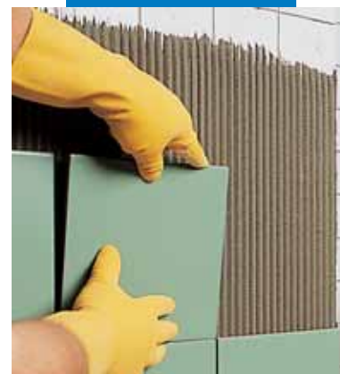
Colocación sobre baldosas viejas
