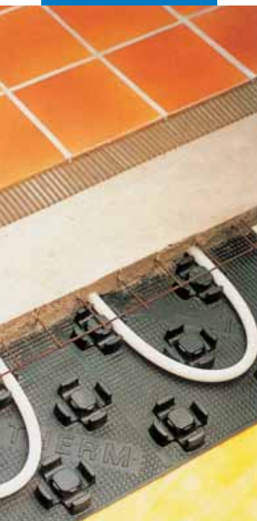
Colocación de cerámica sobre pavimento de calefacción radiante
