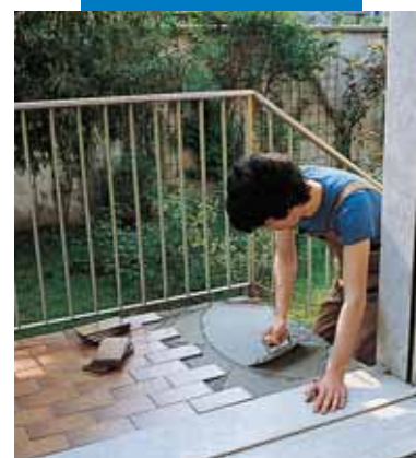
Impermeabilización y posterior colocación con Kerabond+Isolastic
