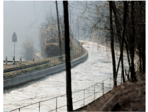
Canal hidroeléctrico Bertini - Como - Italia. Superficies tratadas con Planiseal 88
