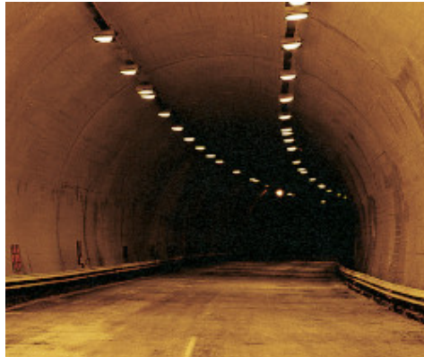
Aplicación de Planiseal 88 blanco por proyección en un túnel de autopista
