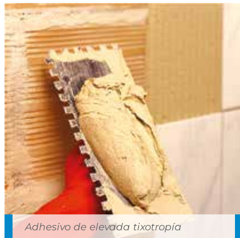
Colocación en pared de revestimiento cerámico
