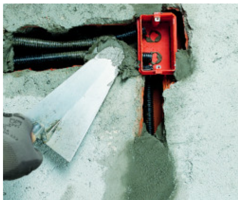
Fijación de cajas y conducciones eléctricas con Lampocem.
