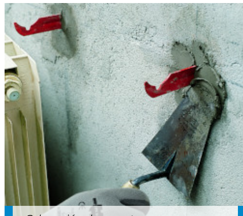
Colocación de soportes para radiadores con Lampocem.
