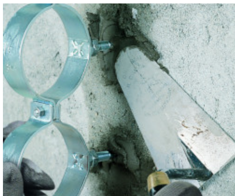
Fijación de abrazaderas para cañerías con Lampocem.
