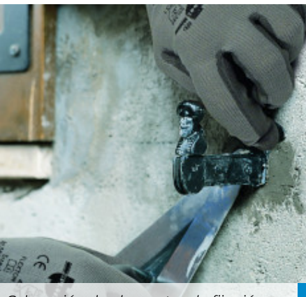
Colocación de elementos de fijación para ventanas con Lampocem.
