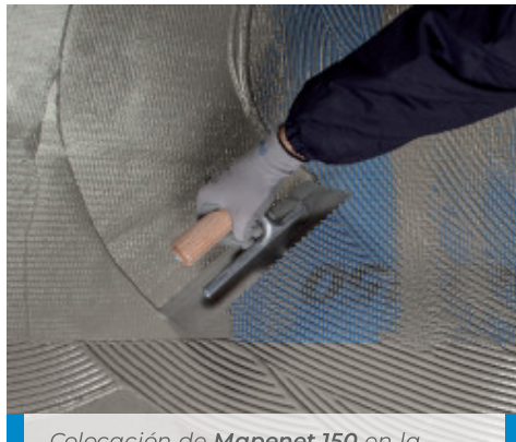
Colocación de Mapenet 150 en la primera capa de Mapelastik Turbo mientras permanece fresca
