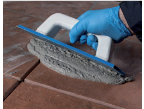
Rejuntado de cerámica con Ultracolor Plus
