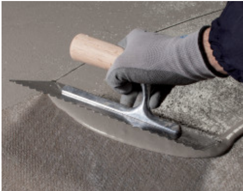
Aplicación de la segunda capa de Mapelastik Turbo sobre la primera capa reforzada con Mapetex Sel N
