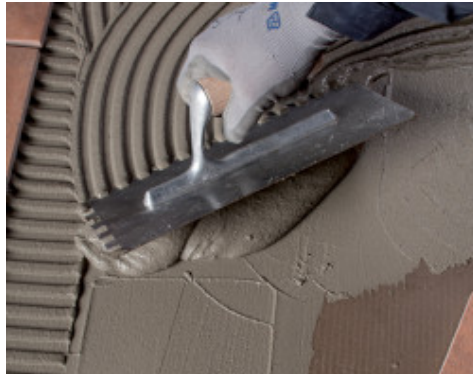
Colocación de cerámica con Elastorapid
