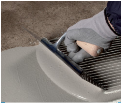
Aplicación de la primera capa de Mapelastik Turbo
