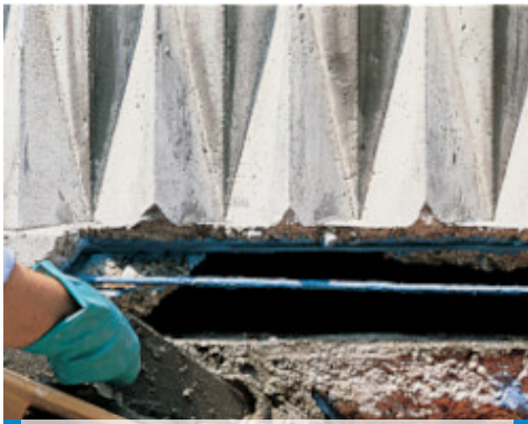
Ejemplo de reparación de un balcón con Mapegrout T40, "fase inicial"
