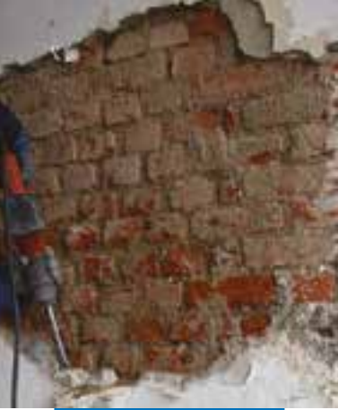
Demolición del revoque existente
