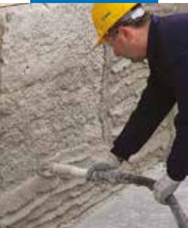
Aplicación de PoroMap Deumidificante con máquina revocadora
