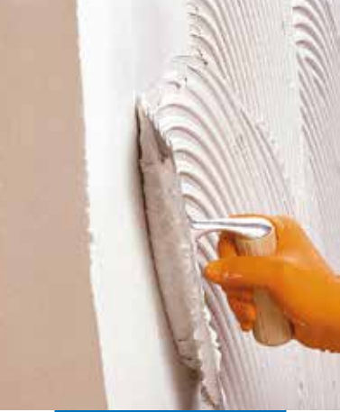
Aplicación de Tixobond White sobre soporte
