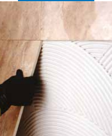
Colocación de gres porcelánico de gran formato en pared
