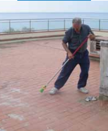
Limpieza del soporte antes de la aplicación de Aquaflex Roof
