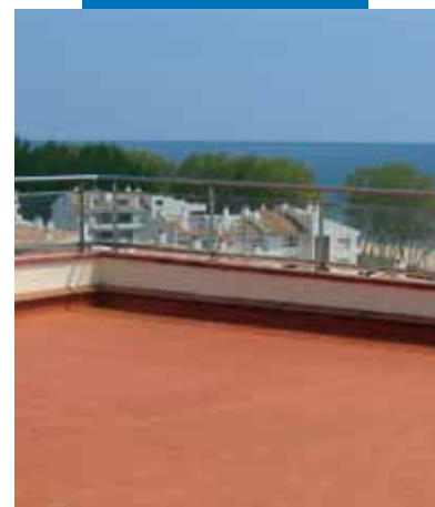
Azotea impermeabilizada y acabada con Aquaflex Roof
