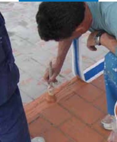
Tratamiento de las juntas de movimiento de una terraza con Mapeband
