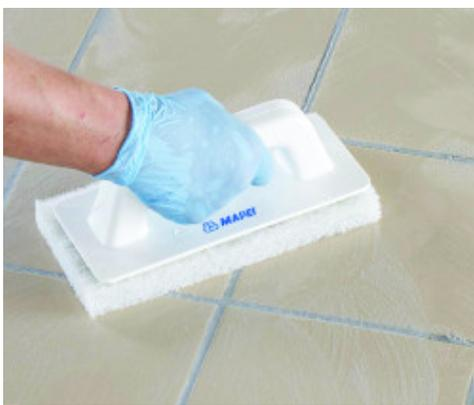
Limpeza de la junta con Scotch-Brite®
