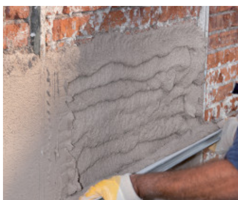
Regleado de Mape-Antique Intonaco NHL
