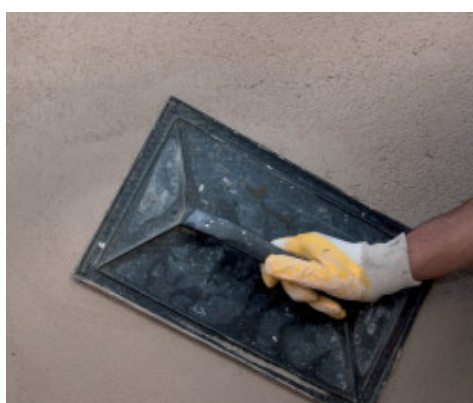
Fratasado de Mape-Antique Intonaco NHL
