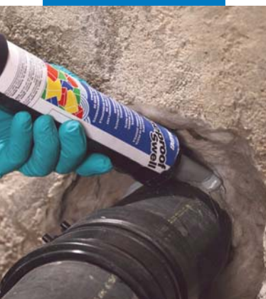
Aplicación de Mapeproof Swell alrededor del tubo
