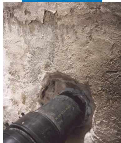
Mapeproof Swell aplicado
