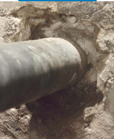
Demolición de la estructura alrededor del tubo
