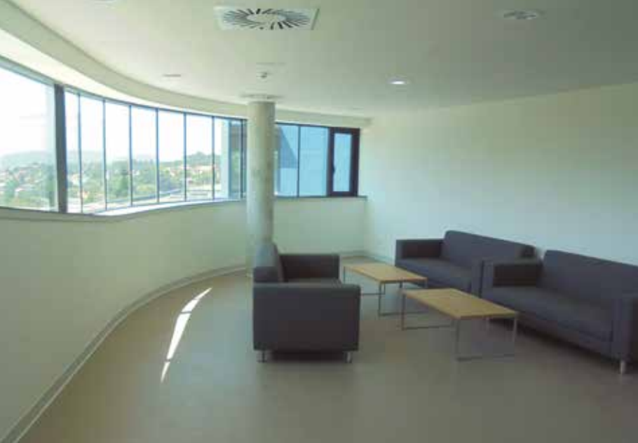
Pavimento de PVC acabado en sala de descanso.
