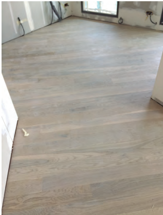
Encolado de madera sobre recrecido TOPCEM con ULTRABOND P980 1K.
