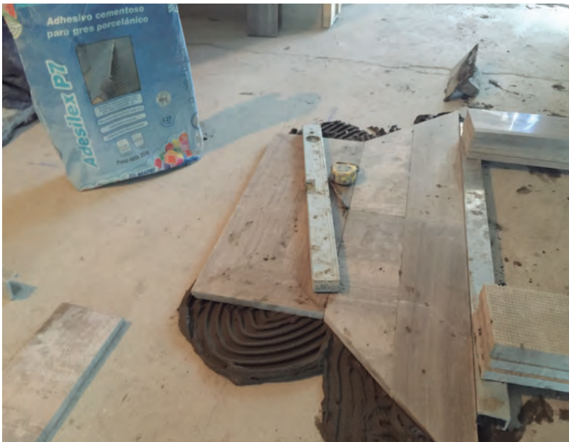
Colocación de cerámica sobre recrecido TOPCEM con ADESILEX P7.
