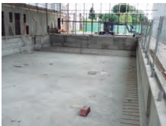
Foto 6 y 7: Vistas del vaso de la piscina.
