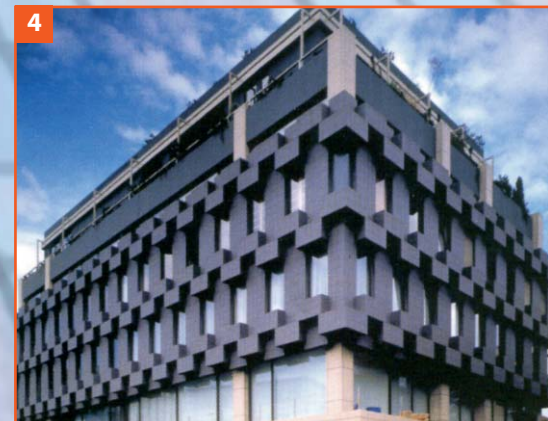
Foto 4: Victoria Towers - Kowloon - China / Revestimiento con gres porcelanato con KERA-BOND + ISOLASTIC y estuca do con KERACOLOR GG + FUGOLASTIC.
