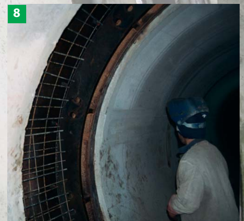
Fotos 1-2-3: Imagen de la sección del tubo, detalles de las juntas entre porciones de tubo.
