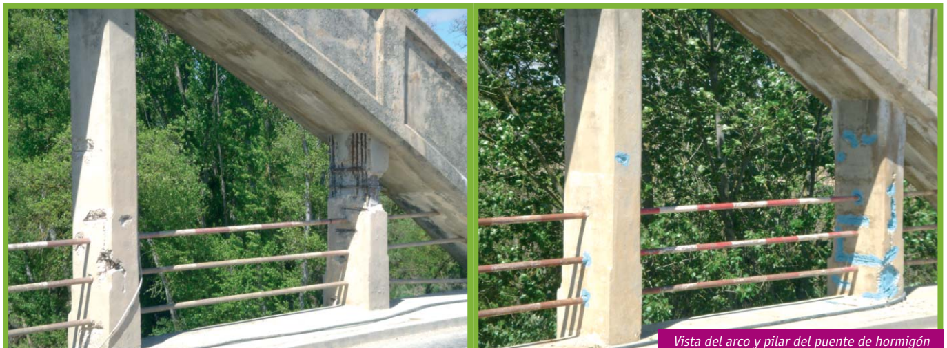
Vista inferior del puente romano
