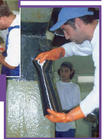
Aplicación del tejido MapeWrap C UNI-AX en un pilar
