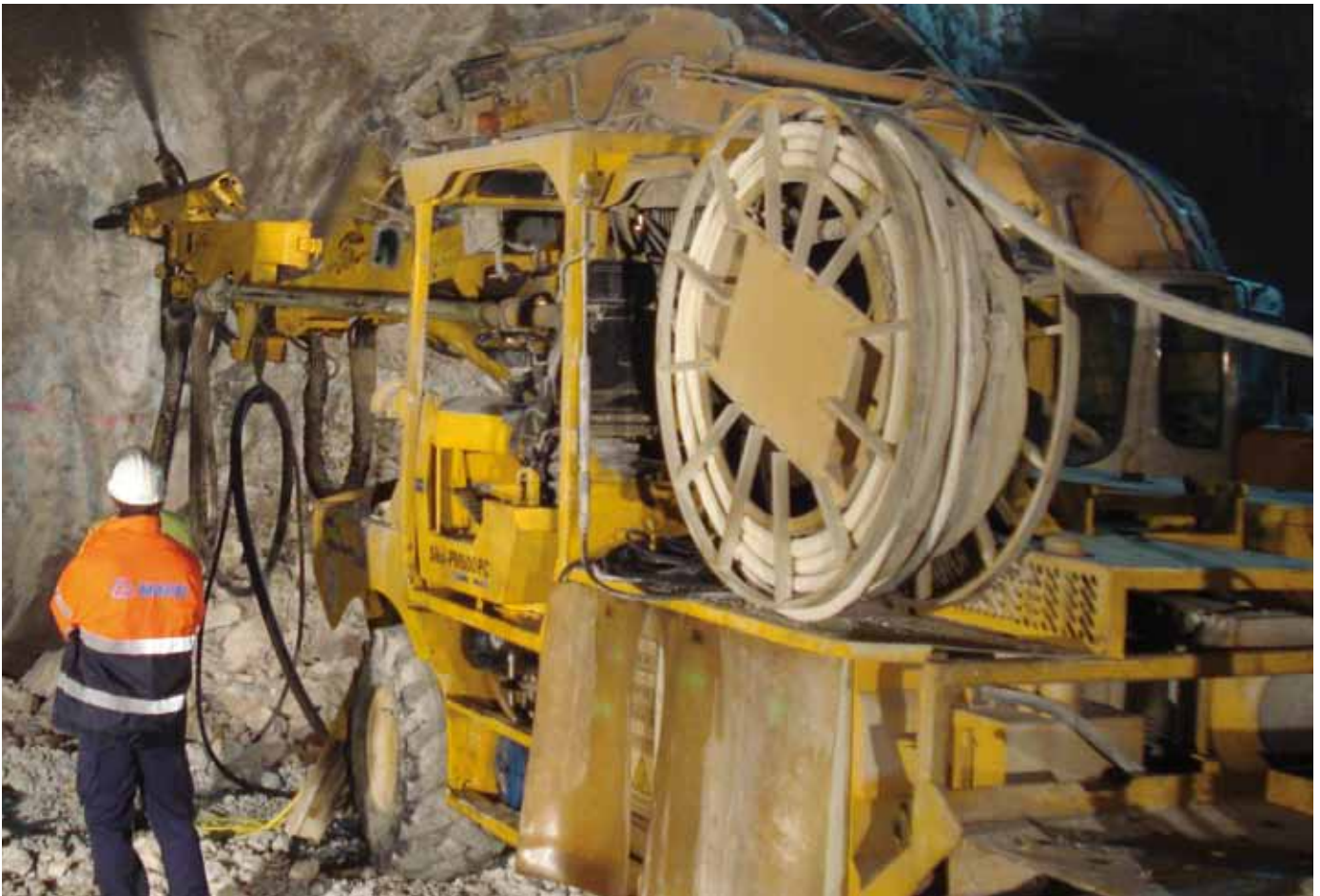
Izquierda: Detalle de aplicación del producto Mapequick AF1000 en el túnel Les Fosses, Desdoblamiento C25-Eix Transversal - COMSA.
