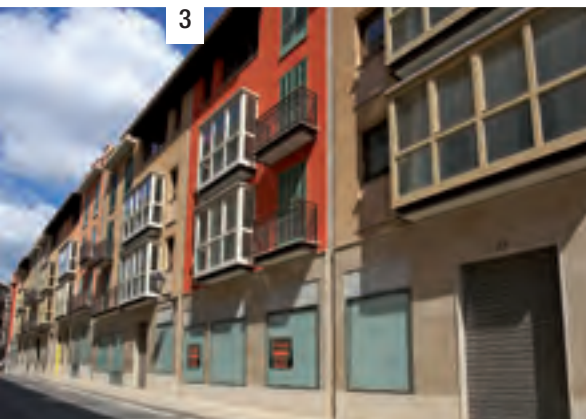
Foto 3. Viviendas y locales recién construidos en Sa Gerreria.
