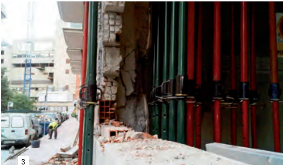
Foto 3. Bajos de edificio apuntalado.
