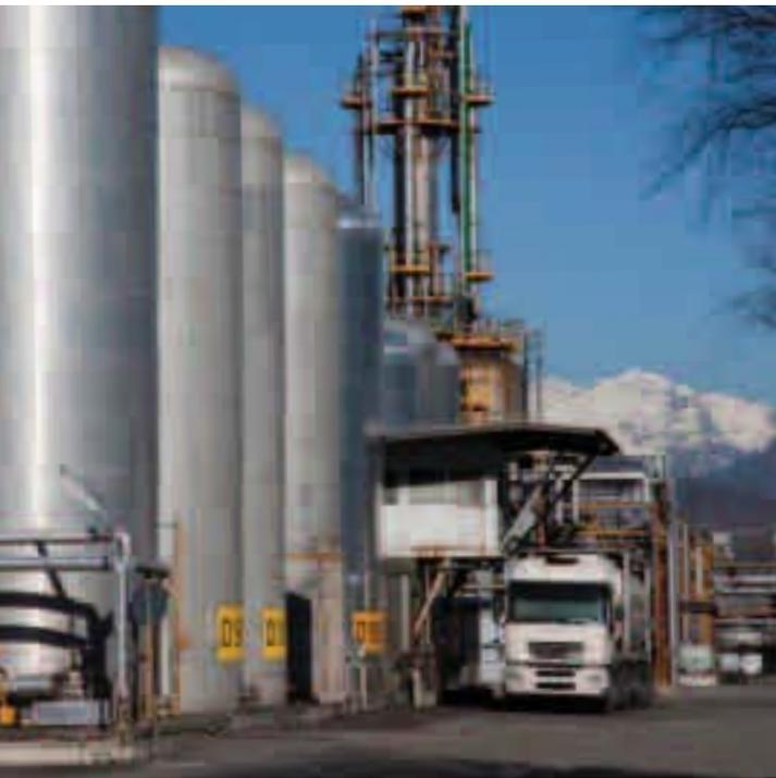
**A la izquierda.** La planta de Vinavil en Villadossola (Italia): tanques de almacenamiento de materiales líquidos crudos y reactores de alta presión para la producción de emulsiones etileno vinil acetato (EVA).
