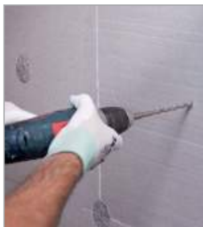
Рис. 6.9 - Сверление отверстия для вставки анкера
