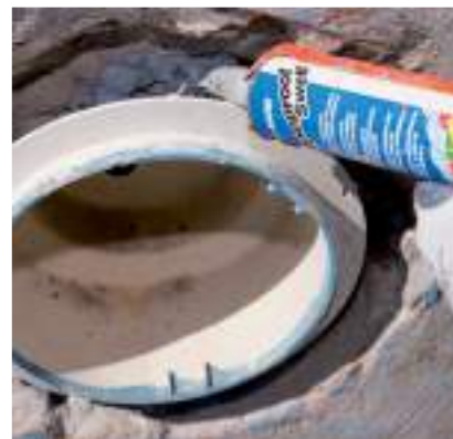
Рисунок 4.2 – Герметизация с помощью пасты MAPEPROOF SWELL
