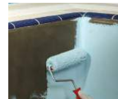
Рисунок 6.2 – Нанесение ELASTOCOLOR WATERPROOF с помощью валика
