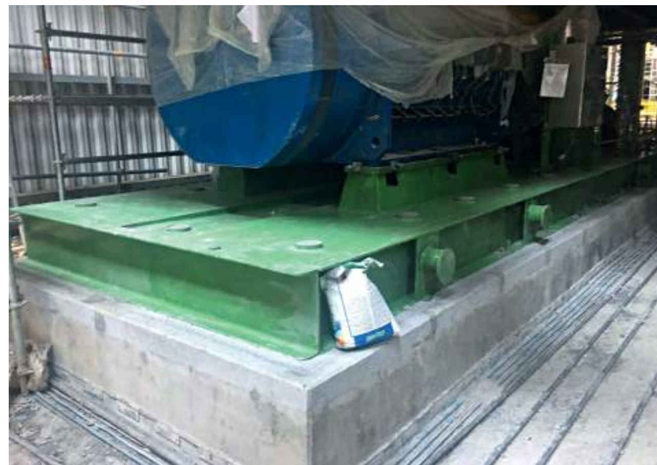
Подливка фундамента турбин, комплексов оборудования и металлоконструкций материалами MAPEI
