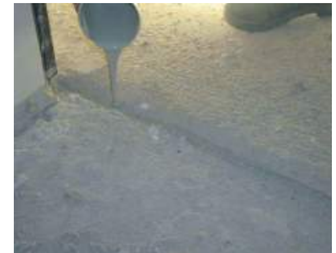
Ремонт трещин с помощью EPORIP
