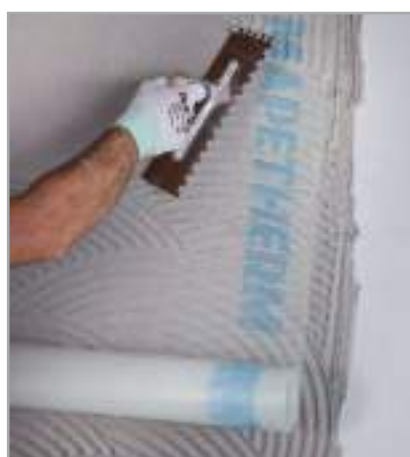
Рис. 6.12 – Укладка MAPETHERM NET
