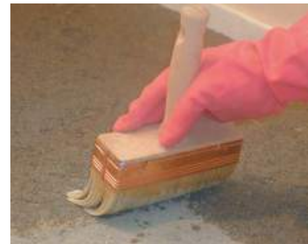
Нанесение PRIMER G кистью на поверхность стяжки
