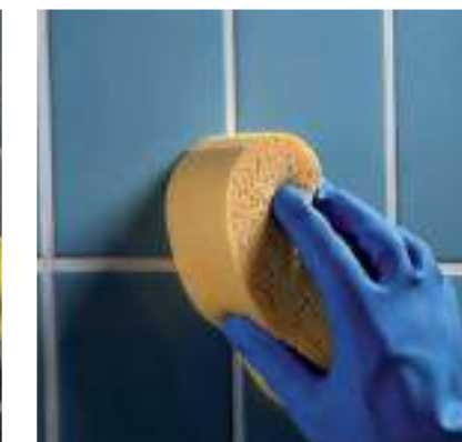
Рисунок 5.8 – Финишная очистка с помощью чистой губки
