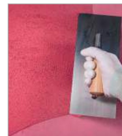
Рис. 6.15 – Нанесение декоративной штукатурки
