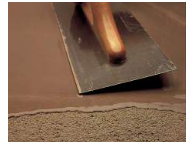
Финишное выравнивание с использованием ULTRAPLAN
