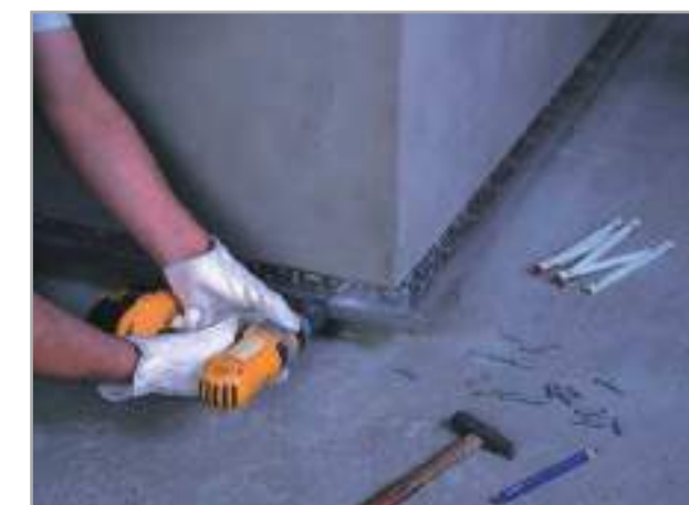
Рис. 6.4 – Закрепите поддерживающие профили с помощью дюбель-гвоздя
