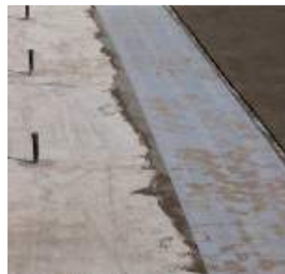
Рисунок 3.7 – Гидроизоляционная обработка с помощью MAPELASTIC SMART и MAPETEX SEL
