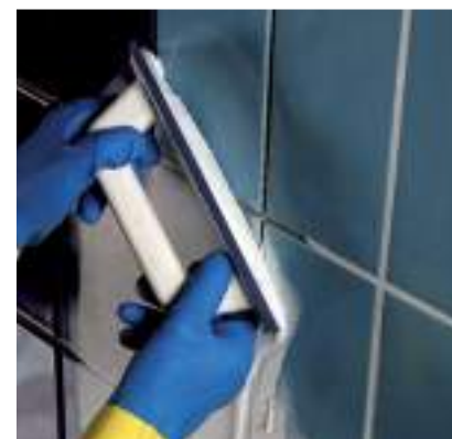
Рисунок 5.6 – Затирка облицовочного материала KERAPOXY CQ
