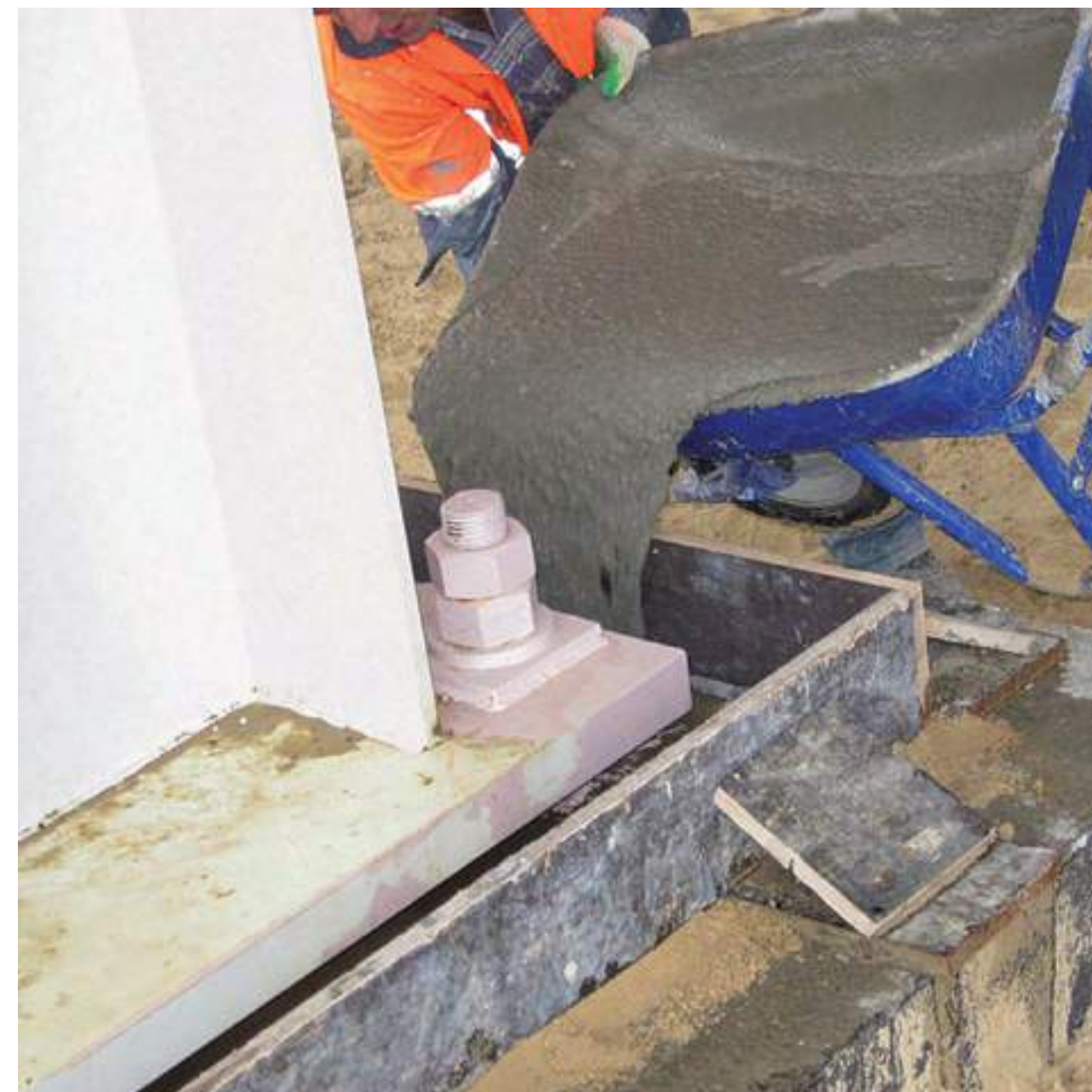
Решение 5. Подливка фундаментных болтов в анкерных колодцах
