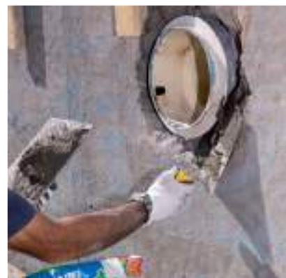
Рисунок 4.3 – Восстановление основания посредством MAPEGROUT 430
