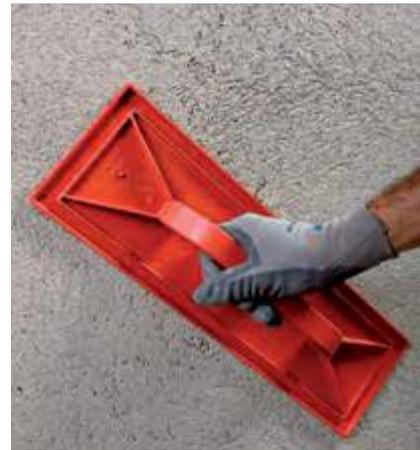
Хотя **Mape-Antique LC** содержит компоненты, которые препятствуют образованию микротрещин, рекомендуется наносить состав, когда стена не подвержена воздействию прямых солнечных лучей и/или ветра. В жаркую и/или особенно ветреную погоду придется принимать особые меры предосторожности, пока штукатурка не затвердеет, особенно в течение первых 36-48 часов. Распыляйте по ее поверхности воду или используйте другие средства, позволяющие предотвратить слишком быстрое высыхание воды для замеса.
