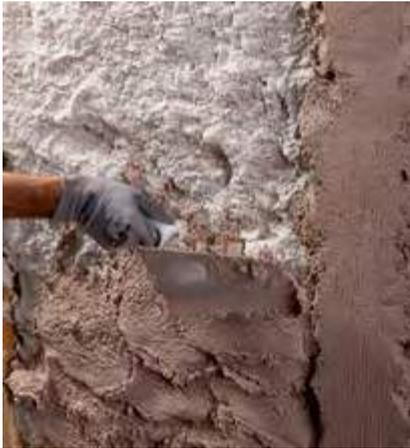
ная с нижней части стены. Если итоговая толщина нанесения превышает 30 мм, наносите **Mape-Antique CC** в несколько слоев. Каждый слой должен наноситься без утрамбовки предыдущего слоя.
