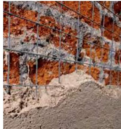
нельзя уплотнять предыдущий слой перед нанесением следующего.
