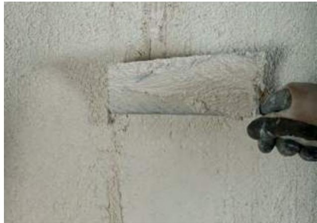
Отделайте поверхность штукатурки с помощью пластиковой, деревянной или губчатой гладилки через несколько часов после нанесения, в зависимости от температуры и окружающих условий. Никогда не давите на поверхность **Mape-Antique MC Macchina**, в противном случае снизится пористость штукатурки и как результат, паропроницаемость кладки будет ухудшена.
