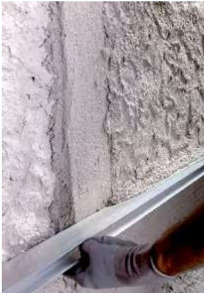
При наличии капиллярного подъема влаги наносите **Mape-Antique MC** только поверх слоя **Mape-Antique Rinzafo** толщиной около 5 мм, которым необходимо покрыть всю поверхность основания для улучшения адгезии штукатурки, выравнивания впитываемости основания и замедления распространения солей.
