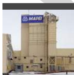
Завод пос. Кикерино, Ленинградская обл.
