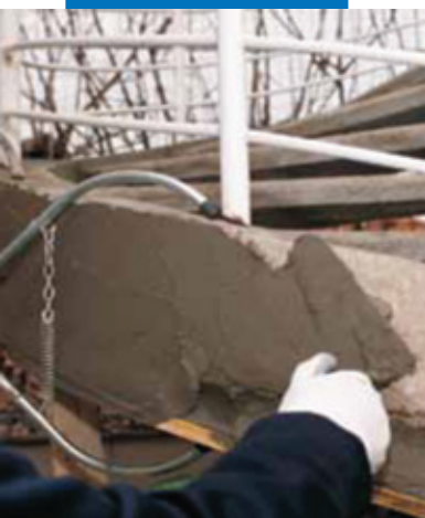
Нанесение MapergROUT 430 при помощи мастерка
