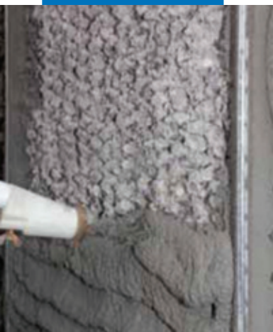
Нанесение MapergROUT 430 набрызгом
