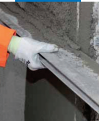
Выравнивание MapergROUT 430 при помощи правила
