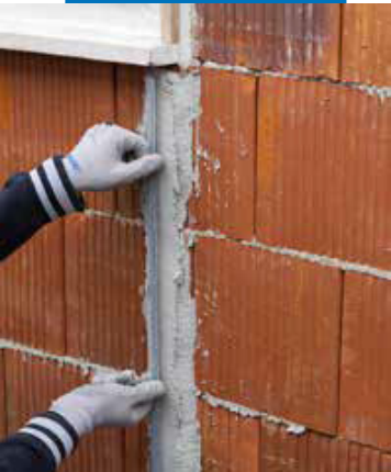
Установка вертикальных направляющих маяков
