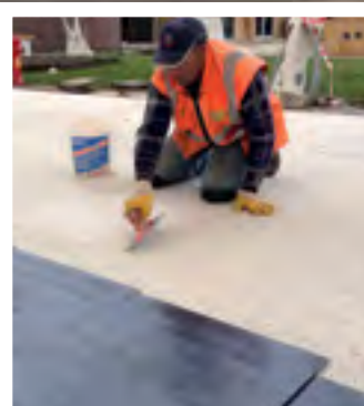
СПРАВА. Покрытия, уложенные для незрячих и слабовидящих людей, фиксировались с помощью ADESILEX G19.
