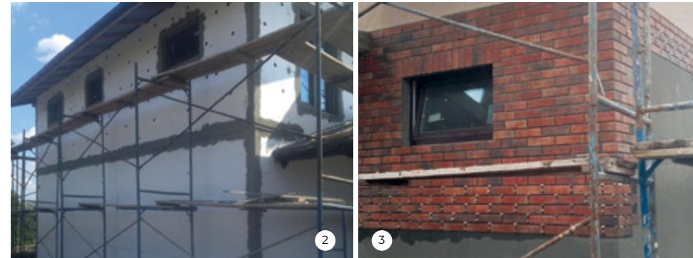
1. Система материалов Mapetherm EPS Clinker применялась при утеплении и отделке фасада загородного дома
