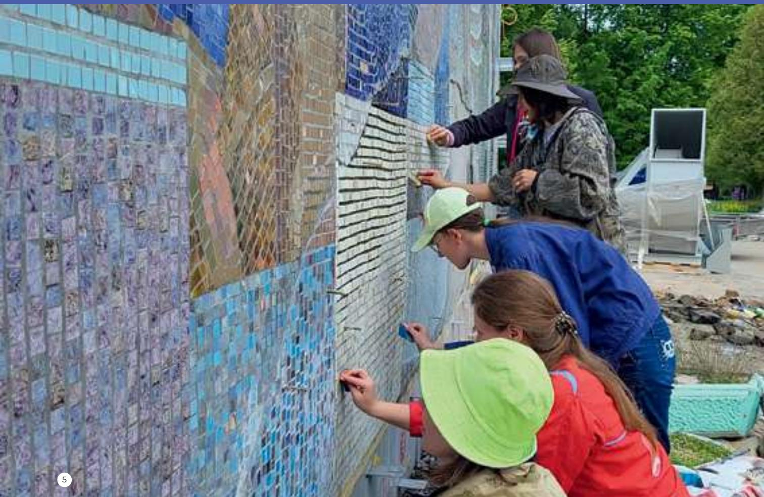
В качестве клеевого состава был предложен Kerabond T-R с добавлением латекса Isolastic. Isolastic представляет собой латексную добавку, применяемую для улучшения характеристики и эластичности клеевого состава, что приводит их в соответствие с требованиями класса C2 (цементный клей улуч-
