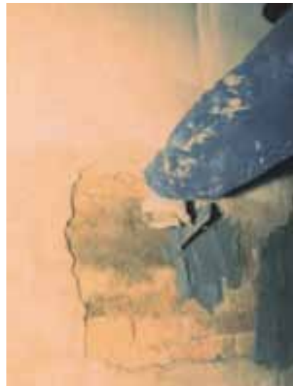
На фото: Ремонт отслоившейся штукатурки с помощью NIVOPLAN+PLANICRETE
