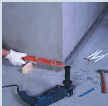
Размещение поддерживающих профилей: проверьте их горизонтальность уровнем
