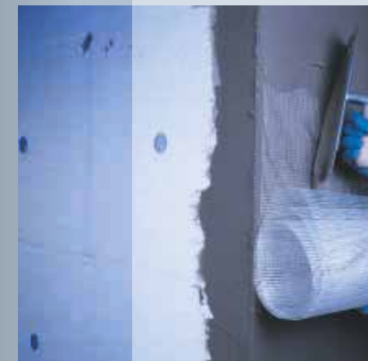
Укладка сетки Mapetherm Net
