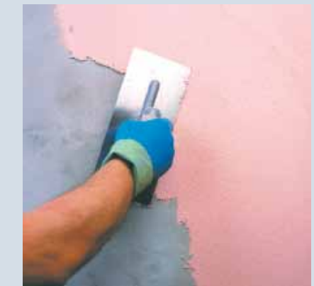
Нанесение слоя отделочной штукатурки
