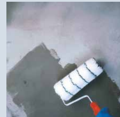
Нанесение базового слоя
