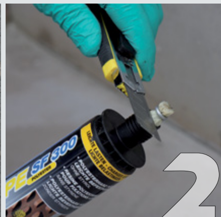
2 Прежде чем надеть статический смеситель на головку картриджа, отрежьте конец ниже кольца.
