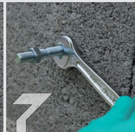
7 После затвердения смолы крепление можно использовать.
