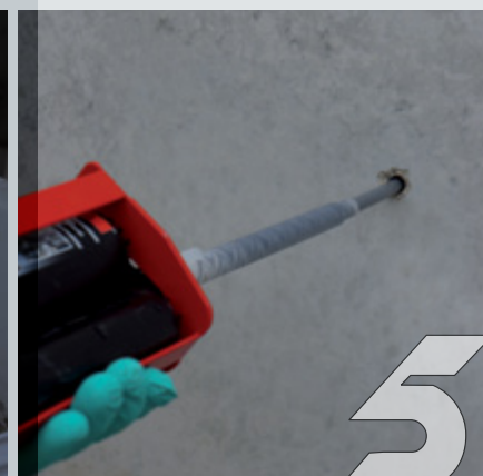
5 Наполните отверстие смолой.
