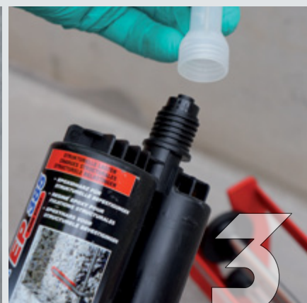
3 Накрутите статический смеситель на головку картриджа.
