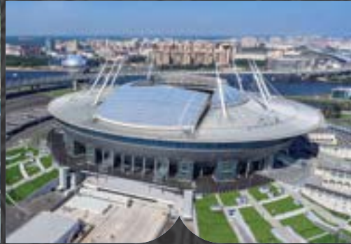
САНКТ-ПЕТЕРБУРГ Стадион Санкт-Петербург
