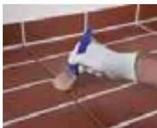
Sve površine na kojima treba da se zapunjavaju spojevi treba da budu suve, kompaktne i bez materijala koji mogu da utiču na prijanjanje.
