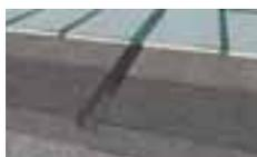
**Radne (kontraktione) spojnice:** formiraju se kroz keramičku oblogu i delimično kroz debljinu podloge (do 1/3), čime ograničavaju mehanička naprezanja izazvana pomeranjem objekta ili dinamičkim opterećenjem.
