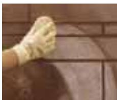
Kada mešavina izgubi plastičnost i matira, obrišite višak mase vlažnim sunderom (kao što je npr. MAPEI celulozni sunder) dijagonalnim povlačenjem. Sunder ispirajte u dve odvojene kofe vode: jedna za uklanjanje viška mase a druga sa čistom vodom za fino pranje.
