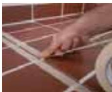
Na ivice pločica zalepite trake kako biste zaštitili površinu i olakšali čišćenje.
