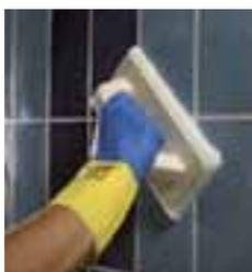
Čišćenje epoksidnih masa treba da se izvede dok je masa još sveža. Čišćenje se izvodi abrazivnim sunđerom (npr. **Scotch-Brite®**) natopljenim vodom, pazeći da ne ispraznite fuge. Sunđer treba da je uvek natopljen vodom i da se često ispira.
