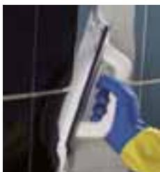
Mešavinu pažljivo naneti MAPEI gletericom u fuge (koje moraju da budu suve) vodeći računa da fuge budu popunjene po celoj dubini. Korišćenjem iste gleterice dijagonalnim potezima uklonite višak materijala.
