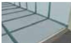
**Obodne spojnice:** formiraju se po obodu keramičke obloge, npr. na mestima gde se podne pločice graniče sa vertikalnim elementima kao što su stubovi, zidovi ili sokle.
