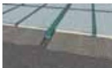
**Dilatazione spojnice:** formiraju se kroz oblogu od keramičkih pločica, koju dele na polja manje površine i time ograničavaju mehanička naprezanja koja su posledica različitih faktora, npr. temperaturnih razlika.
