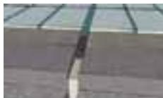
**Konstruktivne (strukturne) spojnice:** formiraju se u skladu sa rasporedom spojeva u konstrukciji i prolaze kroz celu debljinu podloge i keramičku oblogu.
