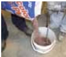
Uz stalno mešanje, sipajte sadržaj vreće u čistu posudu sa odgovarajućom količinom vode ili lateksa kao što je navedeno u tehničkim podacima proizvoda. Mešajte električnim mikserom pri niskoj brzini dok ne dobijete homogenu mešavinu, sačekajte da odstoji 2–3 minuta, a zatim ponovo promešajte pre upotrebe.
