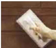
Završna obrada može da se izvede i abrazivnim sunderom (kao što je Scotch-Brite®) ili mašinski, diskom sa abrazivnim filcem. Ako se počne sa čišćenjem dok je masa još uvek plastična, fuga može da se ošteti odnosno da masa izađe a takve fuge su podložnije i varijaciji boje.
