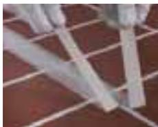
Površinu sveže mase za zaptivanje obradite vlažnim alatom, po mogućnosti sapunicom, pre nego što se formira film na površini. Nakon toga uklonite zalepljene trake sa ivica.
