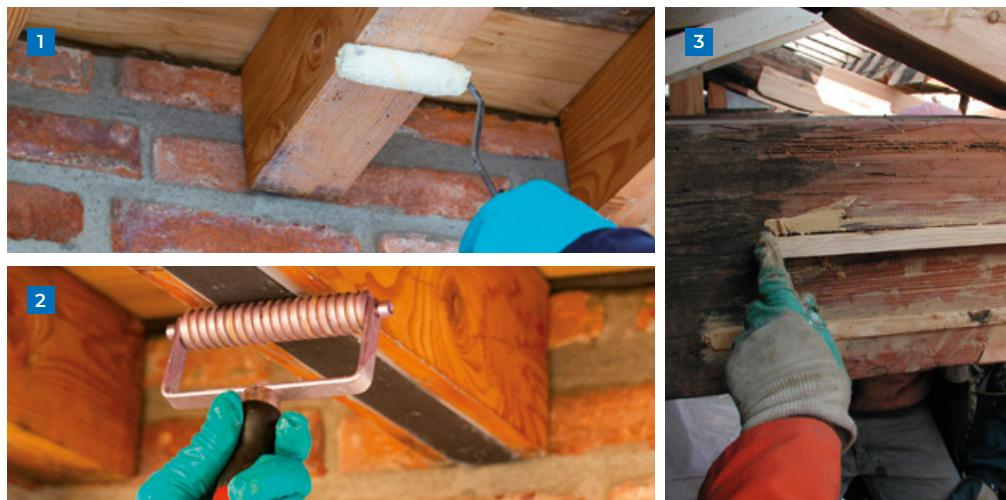
**1** Nanošenje sredstva za impregnaciju **Mapewood Primer 100** na unutrašnju površinu pukotine koju treba ojačati.
