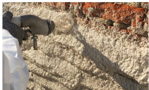
Nanošenje mašinom za malterisanje preko neujednačene podloge.
