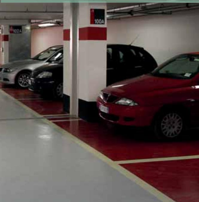
Višeslojni, bešavni poliuretanski sistem sa visokim svojstvom premoščavanja pukotina, za izradu pešačkih površina kao i površina izloženih intenzivnom saobraćaju putničkih vozila, otporan na UV zračenje, debljine od 4 do 4,5 mm, uključujući i spoljašnje površine. Sistem je usklađen sa smernicama OS 11b Direktive nemačkog komiteta za armirani beton i standardom SRPS EN 1504-2.
