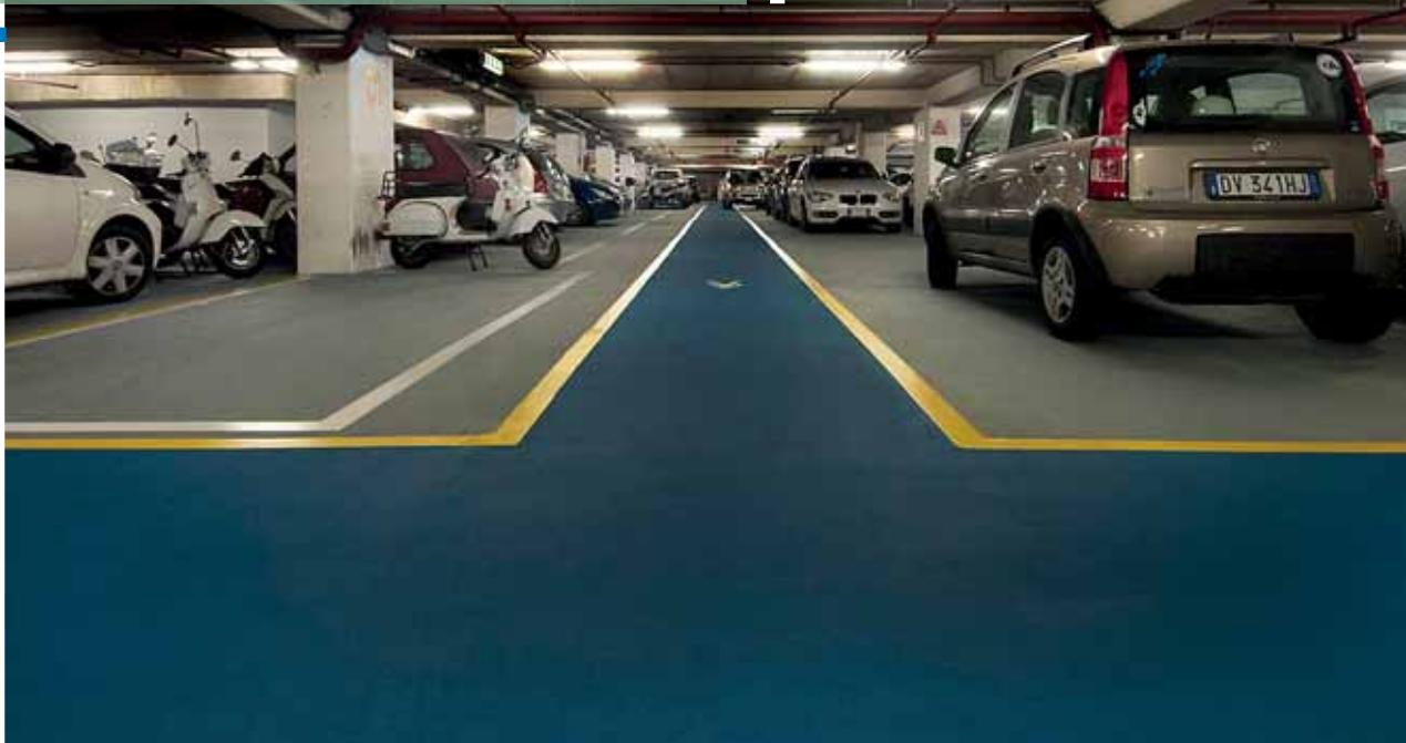
Višeslojni, bešavni sistem na bazi smola za izradu pešačkih površina kao i površina izloženih intenzivnom saobraćaju putničkih vozila, debljine od 3 do 3,5 mm. Sistem je usklađen sa smernicama OS 8 Direktive nemačkog komiteta za armirani beton i standardom SRPS EN 1504-2.
