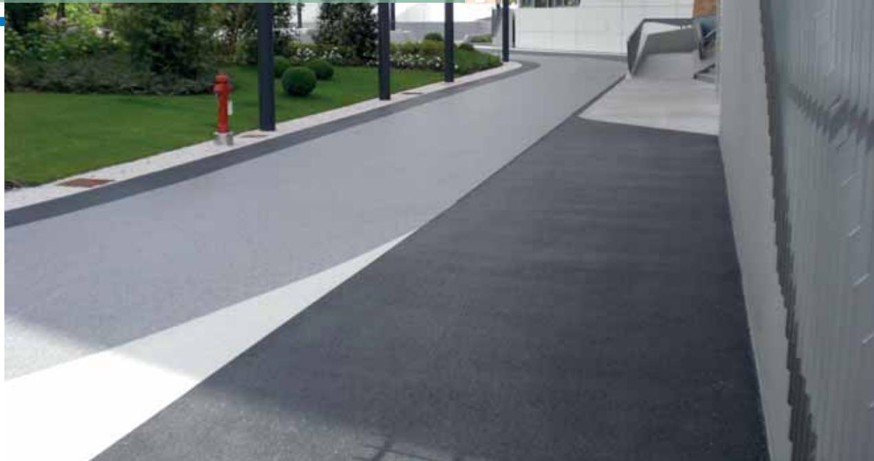
Drenažni sistem na bazi alifatičnih poliuretanskih veziva pomešanih sa prirodnim agregatom (2–4 mm ili 4–8 mm) za izradu dekorativnih spoljašnjih površina.
