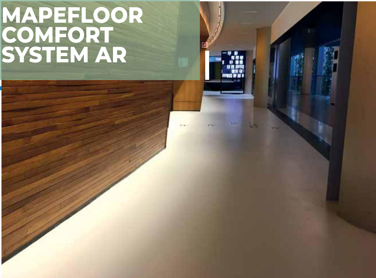
Samoizravnavajući, elastični, aromatični sistem na bazi poliuretanskih smola, otporan na UV zračenje, za izradu obloga debljine 2 mm na unutrašnjim površinama.
