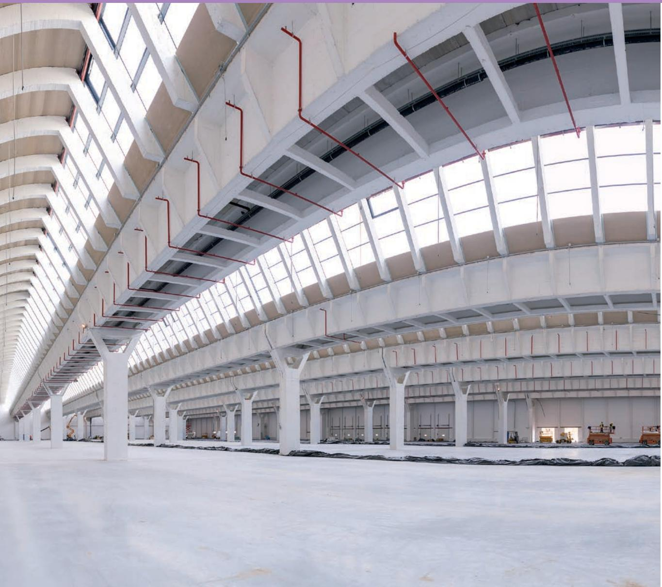
služili više od pola veka. Prostor je podeljen sa 9 uzdužnih i 8 poprečnih osa, sa rasponima od 15 m, odnosno 30 m, sa monumentalnim „Y“ stubovima koji nose dvostrukе gredе za polukružni krov od prefabrikovanog betona.
