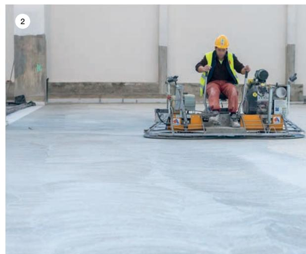
**SLIKA 1:** Razastiranje suvih posipa za učvršćivanje površine preko svežeg betona.
