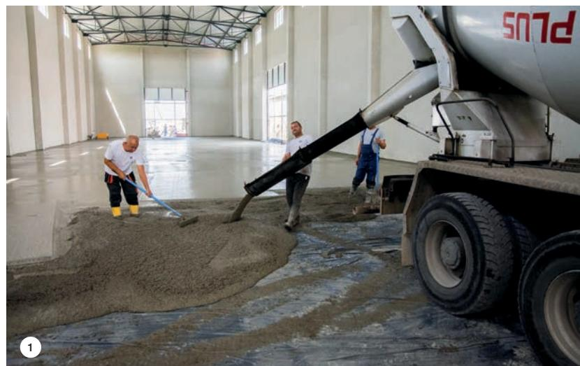
**SLIKA 1:** Direktno izručivanje betona na mesto ugradnje.
