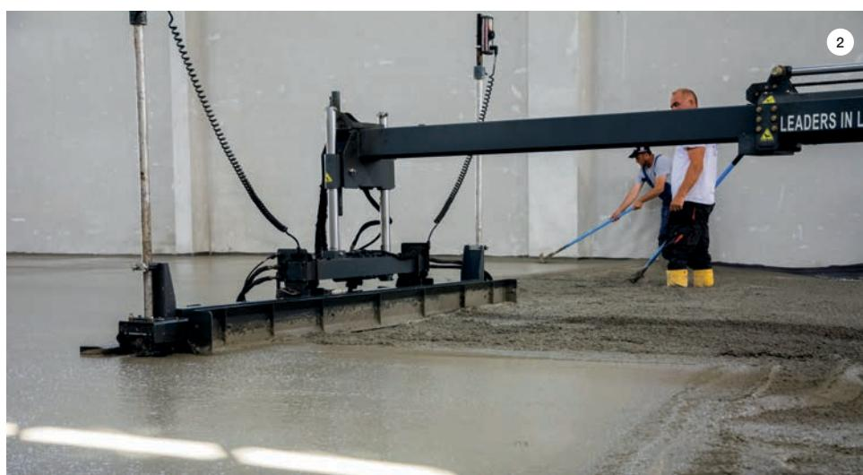
gućnost prilaza kamionske mešalice u sam objekat betoniranje je izvrše- no direktnim izručivanjem betona na mestu ugradnje.
