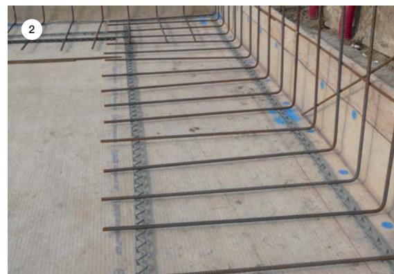
mente u visini od najmanje 20 cm preko kote terena, a trake spajaju sa preklopom od najmanje 10 cm. MAPEPROOF se mehanički fiksira za podlogu uz pomoć zakivaka i podloški MAPEPROOF CD, koji se postavljaju na svakih 30–50 cm. Ovo tehničko rešenje će omogućiti stabilnost preklopa prilikom ugradnje betona i obezbediti strukturni vodonepropusni kontinuitet, što je posebno važno na mestu spojeva vertikalnih i horizontalnih površina.
