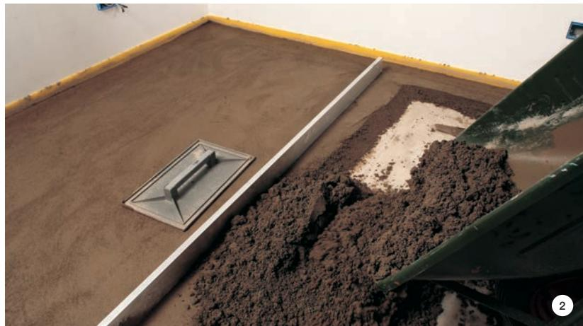
**SLIKA 2:** Izrada estriha upotrebom specijalnog hidrauličkog veziva TOPCEM.
