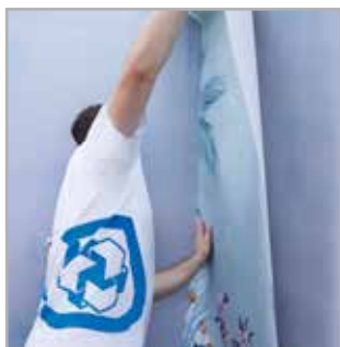
5 Posa di fibra di vetro decorativa Laying of decorative fiberglass
