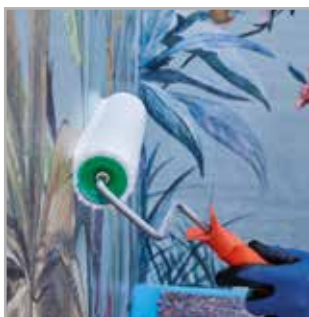
6 Applicazione di MAPECOAT DECOR PROTECTION Application of MAPECOAT DECOR PROTECTION
