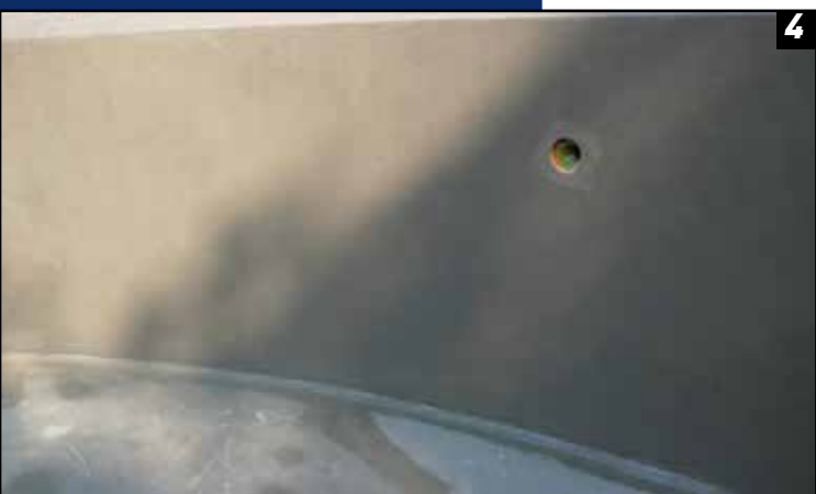
4. Hydroizolácia bazénu Mapelasticom
