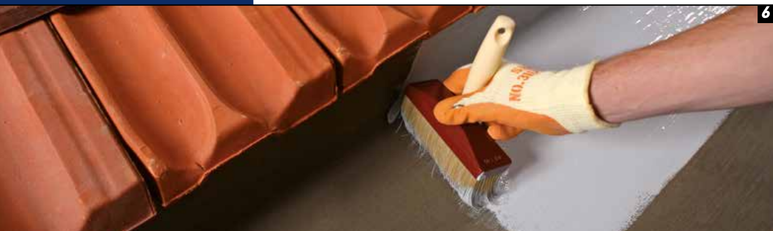
6. Hydroizolácia betónového žľabu Mapelasticom Smart
