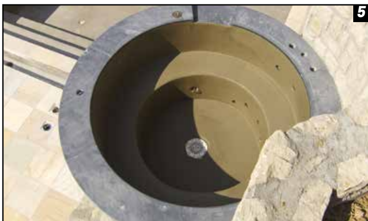
5. Hydroizolácia hydromasážnej vane Mapelasticom
