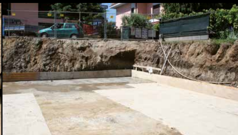
Položenie Mapeproofu pred betonážou dosky
