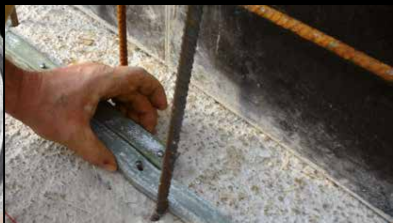
Upevnenie profilu Idrostop B25 na povrch monolitickéj betónovej konštrukcie
